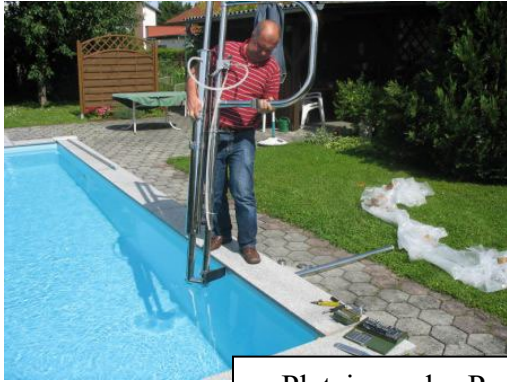
Platzieren des Poolliftes am Poolrand
