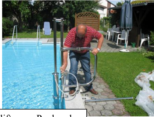
Platzieren des Poolliftes am Poolrand
