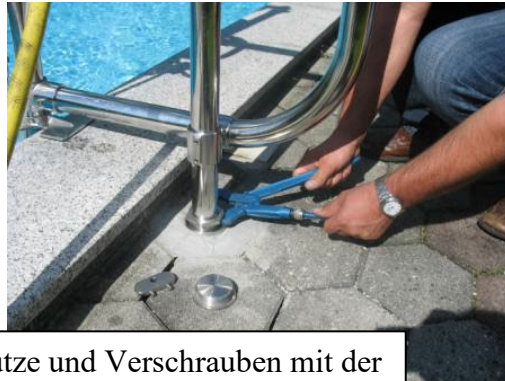
Platzieren des Poolliftes am Poolrand
