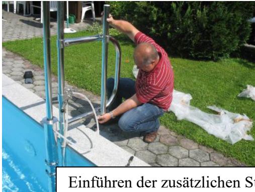
Platzieren des Poolliftes am Poolrand
